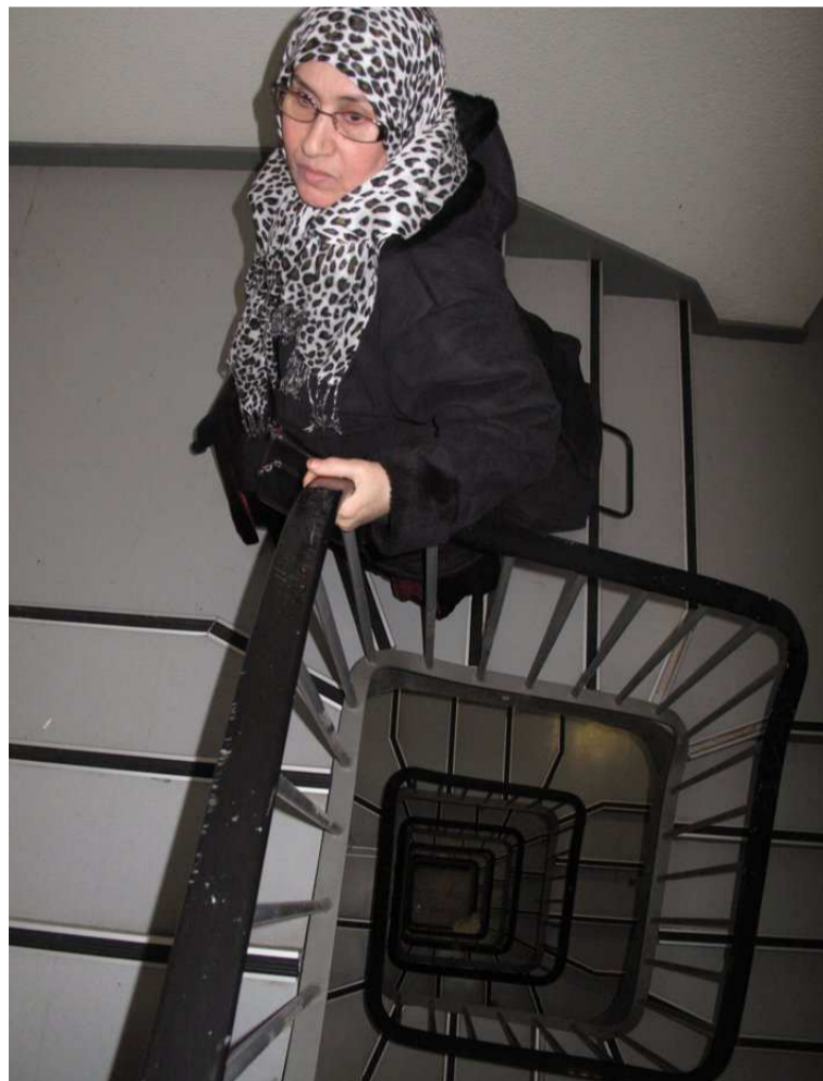
Trappes, samedi. A l'image de Fatiha, les résidents des derniers étages de l'immeuble, jeunes comme plus âgés, souffrent pour atteindre leur logement depuis trois mois et demi. (LP/L.M.T.)
